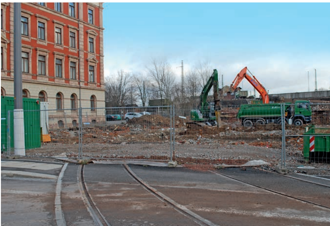
Abbrucharbeiten ehemaliger Speisesaal Deutsche Post
