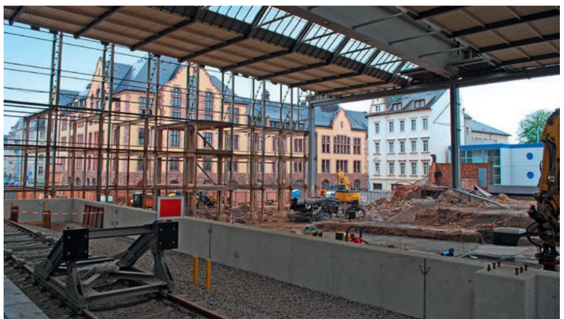
Umbau und Ertüchtigung der Stahlkonstruktion Stirnseite
