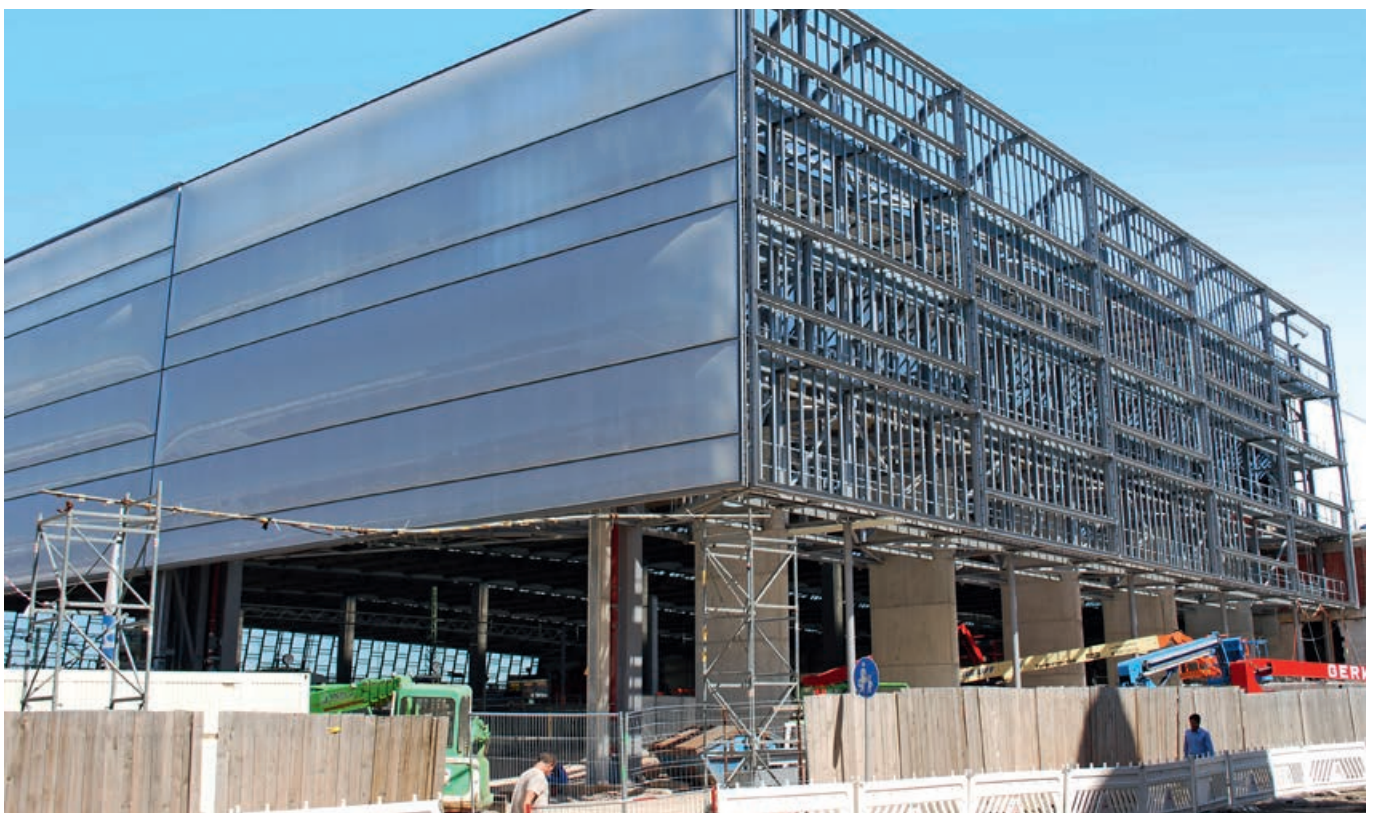
Montage Außenfassade Querbahnsteiggebäude
