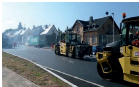
2014: Ausbau B 174 Chemnitz | Bauherr: Stadt Chemnitz
