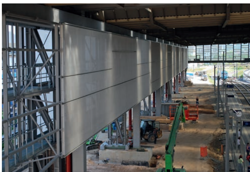
Montage Innenfassade Querbahnsteiggebäude
